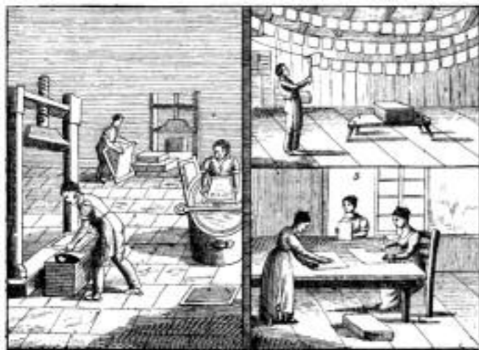
Um 1830: Papierschöpfen - Pressung - Trocknung
