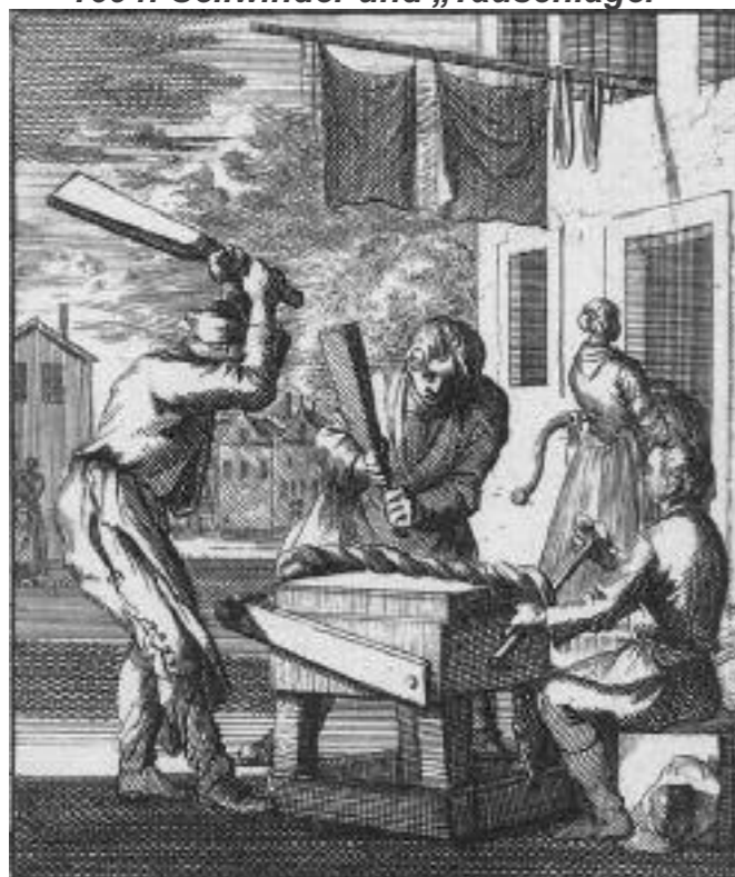
1694: Seilwinder und „Tauschläger“
