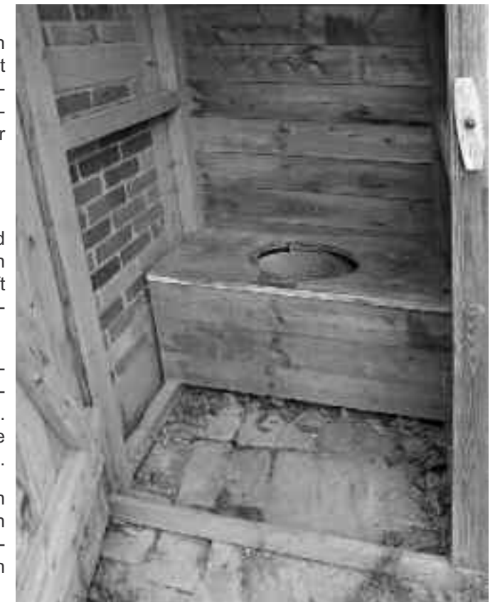
Unten: Anbau mit Plumpsklo und Eimer
