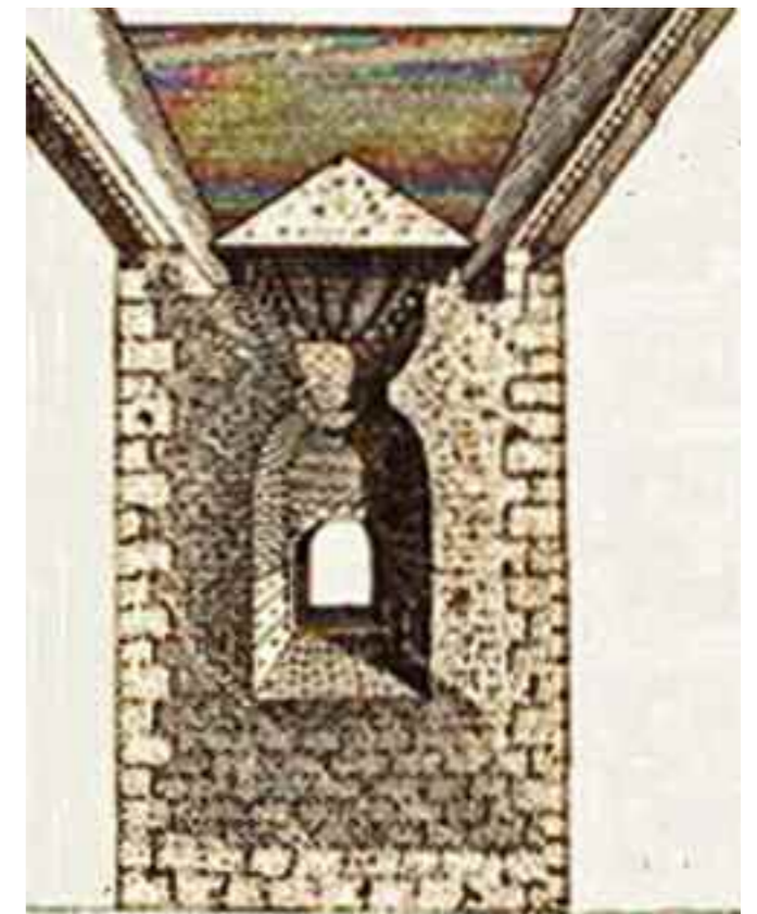
Bronsthaus oder Brosterhaus, nach dem Prinzip eines Flachsofens oder einer Darre
